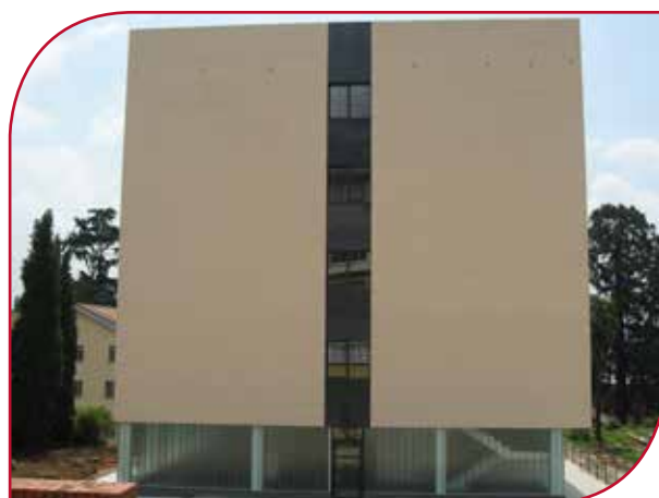
Flatgebouw "Edificio Fundoma" te Asturië (Spanje)
